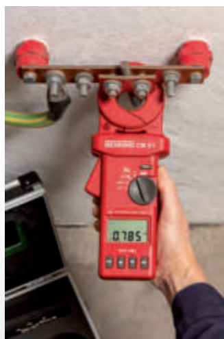
Messung des Erdschleifenwiderstandes eines Anlagenerders
