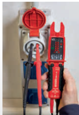
Spannungsmessung und Drehfeldrichtungsprüfung
